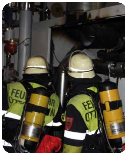
Der Atemschutztrupp kontrolliert den Gasmotor auf glimmende Teile.
