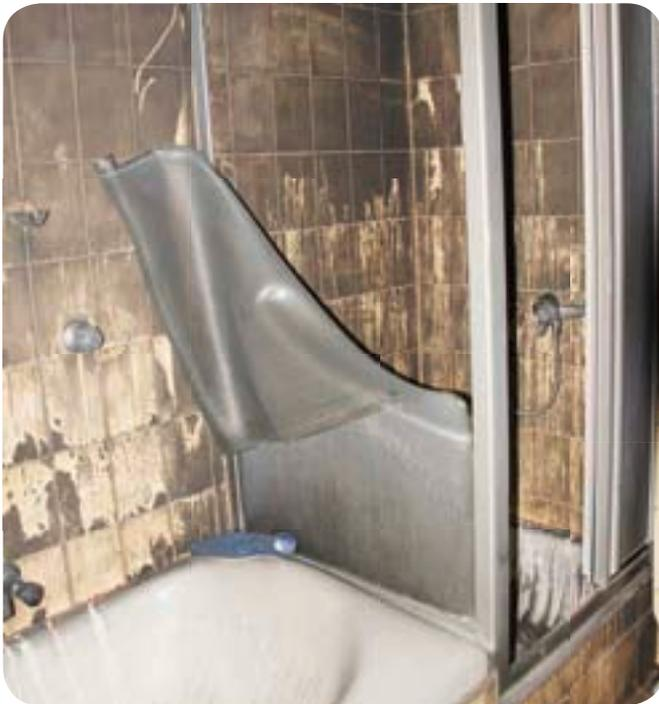
Im ausgebauten Dachgeschoss staute sich die Hitze und brachte dort unter anderem die Kunststoffteile im Bad zum Schmelzen.
