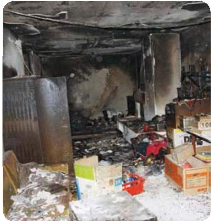
Die Hitze im Brandraum war so hoch, dass der Putz großflächig von der Decke platzte.
