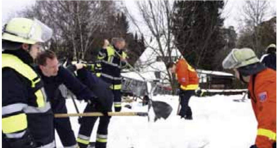
In schweißtreibender Handarbeit befreiten die Einsatzkräfte das Dach eines Kindergartens vom Schnee.
