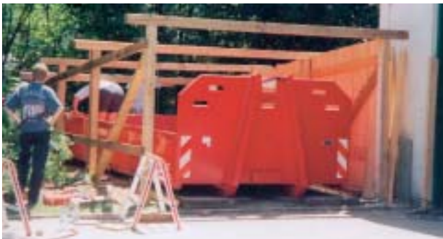
Für die Mulde des Wechselladesystems entsteht ein wettergeschützter Stellplatz
