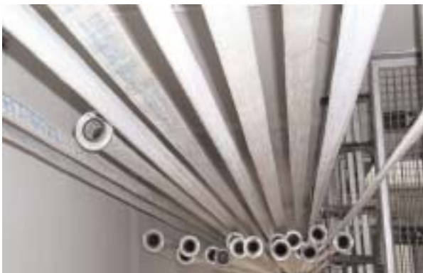
Erkennbar ist das Gerätehaus am Schlauchturm. Darin hängen die Schläuche zum Trocknen.
