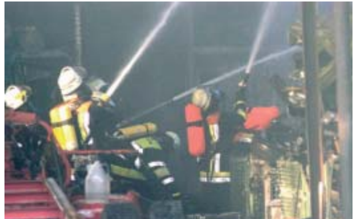
Löscharbeiten in Höhenkirchen. Eine Lagerhalle mit Autoteilen steht in Flammen. Foto: Thomas Gaulke - FIRE Foto
