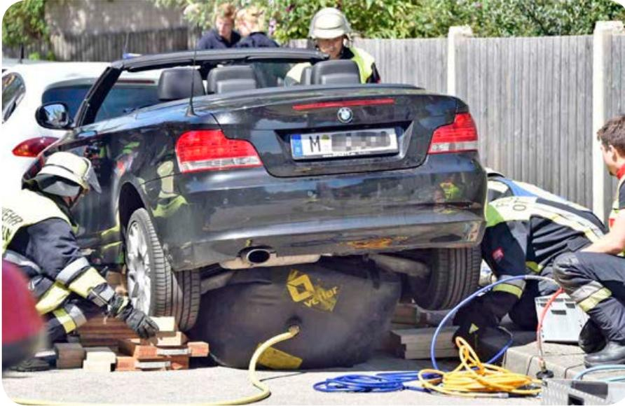
8. August: Der Pkw wird mit einem pneumatischen Hebekissen angehoben
