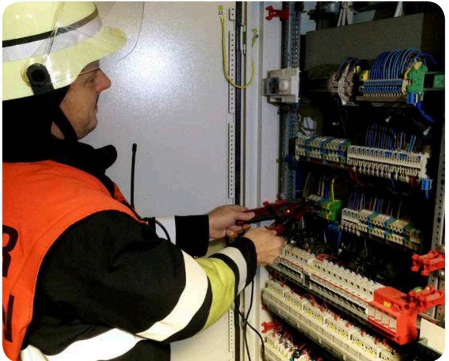
14. November: Prüfen der Spannungsfreiheit nach Brand im Stromverteilerkasten
