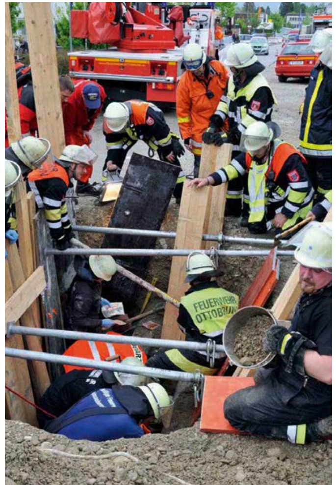
Zuerst sicherten die Einsatzkräfte die Grube mit Brettern, Balken und Bauspindeln. Dann gruben sie teilweise mit bloßen Händen den Verschütteten aus.
