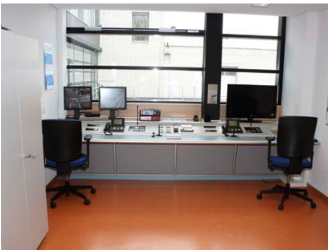
Modernste Kommunikationstechnik findet sich in der Einsatzzentrale.
