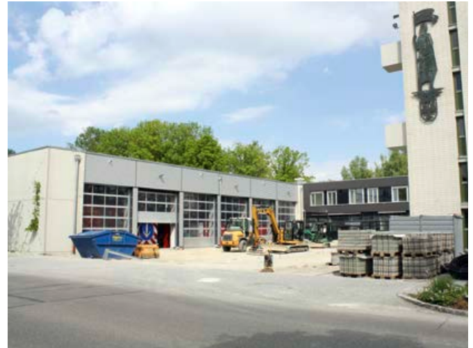
Als letztes erfolgten die Pflasterarbeiten im Hof zwischen dem früheren Schlauchturm, dem 2010 errichteten Sozial- und Werkstätten trakt sowie der Fahrzeughalle.
