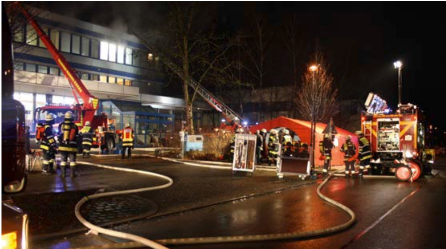
Ein Gewerbegebäude kurz vor seinem Abriss bietet ideale Voraussetzungen für eine groß angelegte Einsatzübung.
