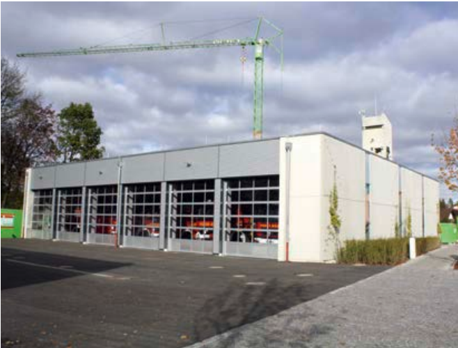
Als erstes wurde die Fahrzeughalle mit 12 Stellplätzen errichtet. Auf ihrem Dach befindet sich eine Photovoltaikanlage. Zu jeder Seite fahren sechs Fahrzeuge hinaus.
