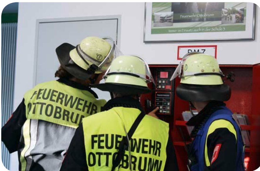
Feuermelder: An der Brandmeldezentrale erkennt die Feuerwehr, welcher Melder ausgelöst hat.
