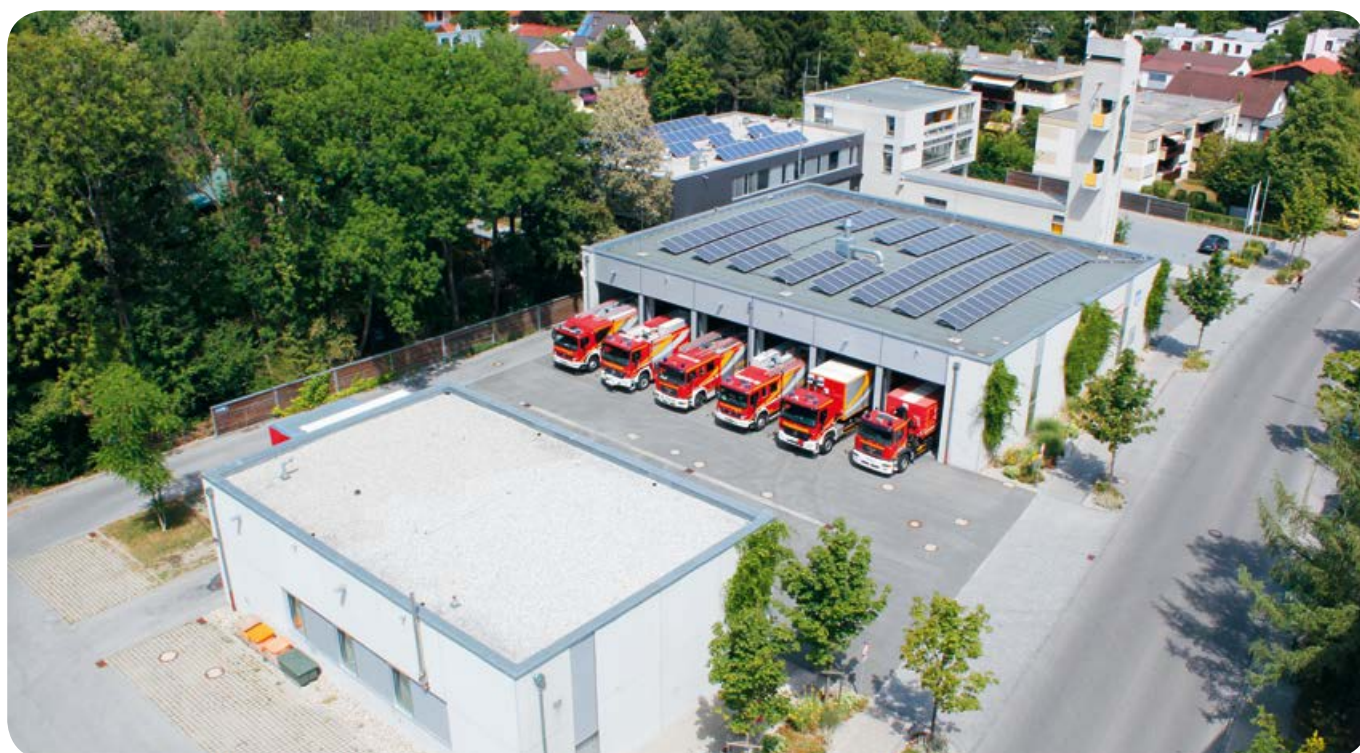
Auf den Dächern des Verwaltungs- und Werkstättentrakts (schwarzer Baukörper) und der Containerhalle (links) könnten nach Vorschlag der Feuerwehr Stockwerke mit Wohnungen aufgesetzt werden.
