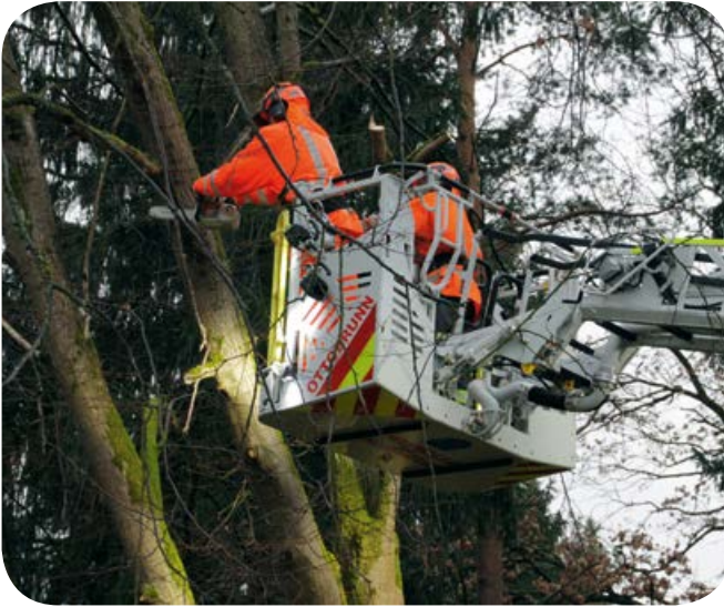
Am 04.01.2018 beseitigte die Feuerwehr in einem Sturm von der Drehleiter aus starke Äste, die auf einen Weg zu fallen drohten.
