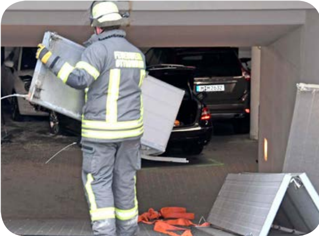
Der Pkw durchbrach das Rolltor in der Tiefgaragenabfahrt. Die Feuerwehr beseitigte die beschädigten Torelemente, um einen ungehinderten Zugang zur Einsatzstelle zu bekommen.
