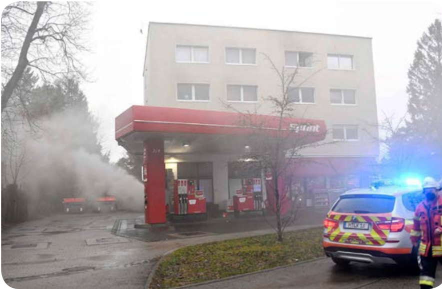
Der Rauch aus der brennenden Tiefgarage nebelte die Umgebung der Einsatzstelle ein.
