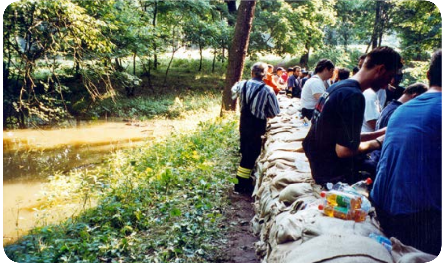
Der Wall bei Großkühnau wurde mit Sandsäcken erhöht. Links überflutete der Fluss Mulde langsam die Parklandschaft. Nun durfte wohlverdient Pause gemacht werden.
