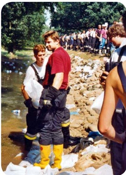
Hunderte Einsatzkräfte aus mehreren Bundesländern reichten in langen Kolonnen Sandsäcke auf dem Wall weiter und befestigten ihn.
