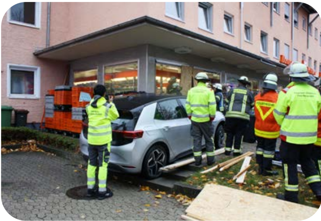
17.11.2023: Ein Pkw war beim Ausparken die Treppenstufen vor einem Drogeriemarkt in der Putzbrunner Straße hochgefahren und gegen das Gebäude gestoßen.
