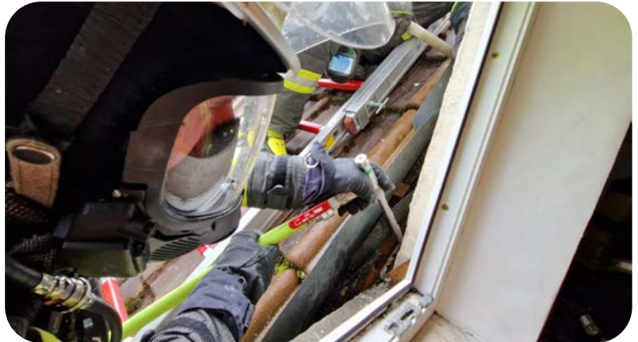
21.5.2023: Mit in den Schlitz zwischen den Wänden eingeschlagenen Löschsonden gelang es den Einsatzkräften, den Brand zu löschen.
