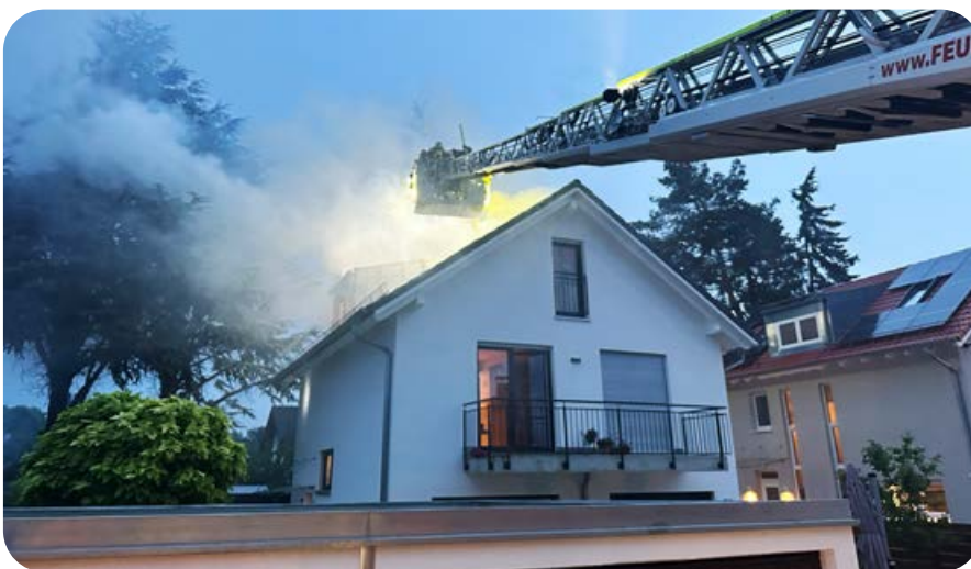
22.6.2023: Nach einem Blitzeinschlag brannte es im Dach eines Wohnhauses. Über die Drehleiter konnte das Feuer gelöscht werden.
