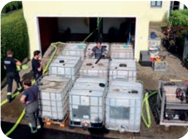
04.06.2024: Das abgesaugte Öl-Wasser-Gemisch lagerten die Feuerwehren in IBC-Containern. Dort setzte sich die Ölschicht ab und konnte zur Entsorgung von Saugwagen abtransportiert werden.
