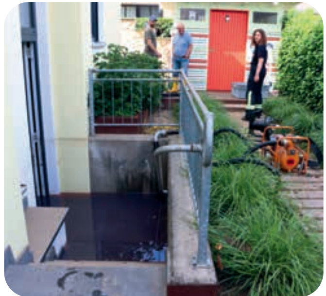
04.06.2024: Das Gemisch aus Heizöl und Wasser steht im Keller. Mit der Mineralölumfüllpumpe wird die oben schwimmende Ölschicht abgesogen.
